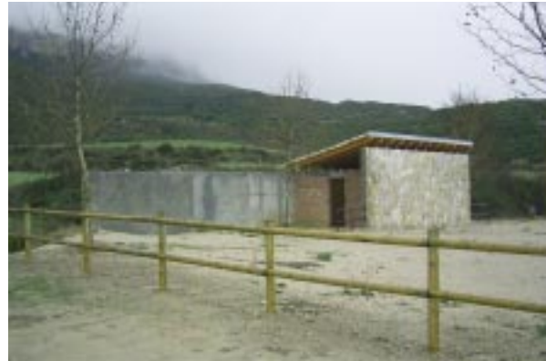
Vista de los aseos de la Foz de Lumbier, construidos al amparo del Acuerdo-Base.
